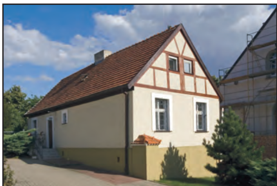
Oficjalna przy ul. Łaskiego to jeden z najstarszych domów w mieście. Tak wyglądała zapewne XVIII-wieczna zabudowa Gniezna. Fot. JG
