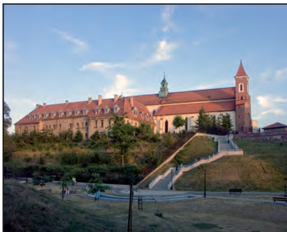
Posadowiony na stromiźnie wału klasztor oo.Franciszkanów stanowił integralną część systemu obronnego miasta. Na zdj. północna fasada klasztoru wraz z nawą boczną. Fot. JG
